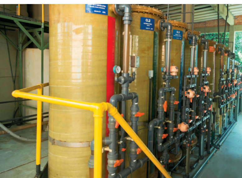
Estação de Tratamento das águas de lavagem da galvanoplastia em circuito fechado com processo de resina de troca iônica.
