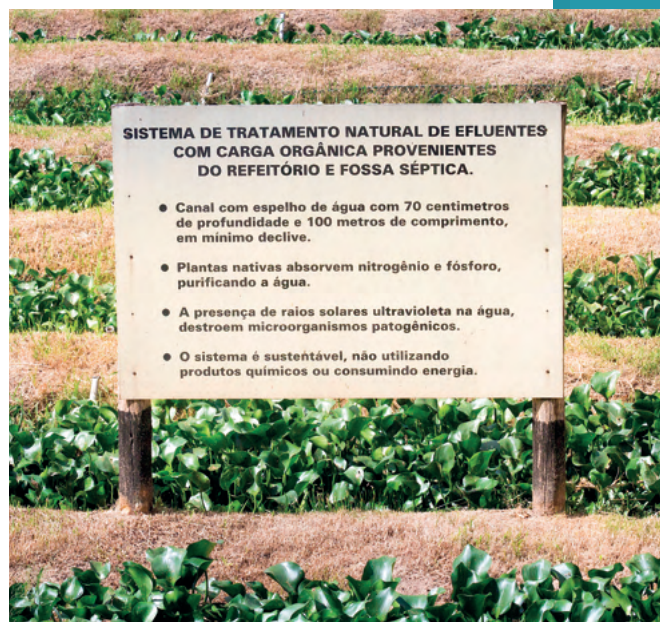
Sistema de Tratamento Natural de Efluentes com carga orgânica provenientes do refeitório e fossa séptica.
