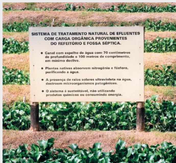
Sistema de tratamento natural de efluentes com carga orgânica provenientes do refeitório e fossa séptica.
